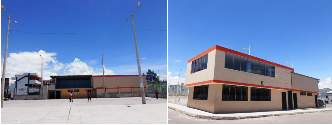
Canchas múltiples y Sede barrial de Huachi Totoras
