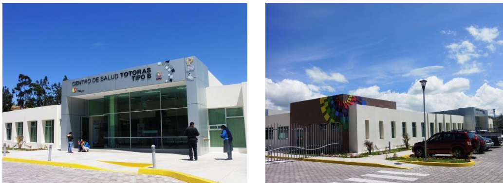
FIGURA 7 Instalaciones de Salud parroquia Totoras
